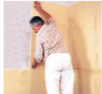
Dämmen der Aussenwände mit der Superwand-Dämmplatte DS®
