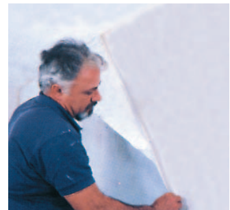
Aufbringen der Tapete
