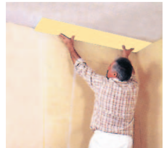
UNIVERSAL-Dämmkeil für Decken- zone und einbindende Innenwand
